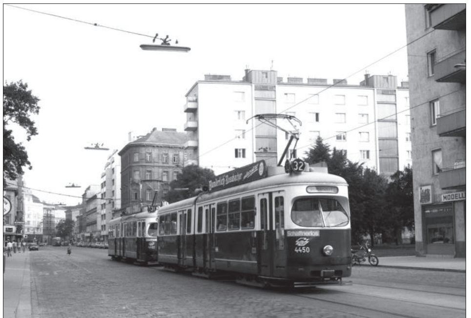
Wegen Gleisbauarbeiten auf der Kreuzung Klosterneuburger Straße/ Wallensteinstraße wird die Linie 32 über die Jägerstraße umgeleitet.
