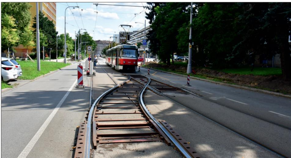
In der Anfangs- und Endstelle Klusáčkova wird über eine Kletterweiche gewendet. Daher werden auf Linie X12 Zweirichtungswagen, KT8, 45T und Heck-an-Heck gekuppelte T3 eingesetzt.
