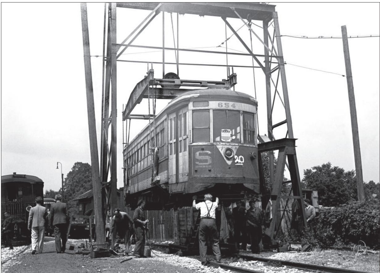
Abladen der Wagen aus der dritten Lieferung mittels Portalkran in Rodaun.
